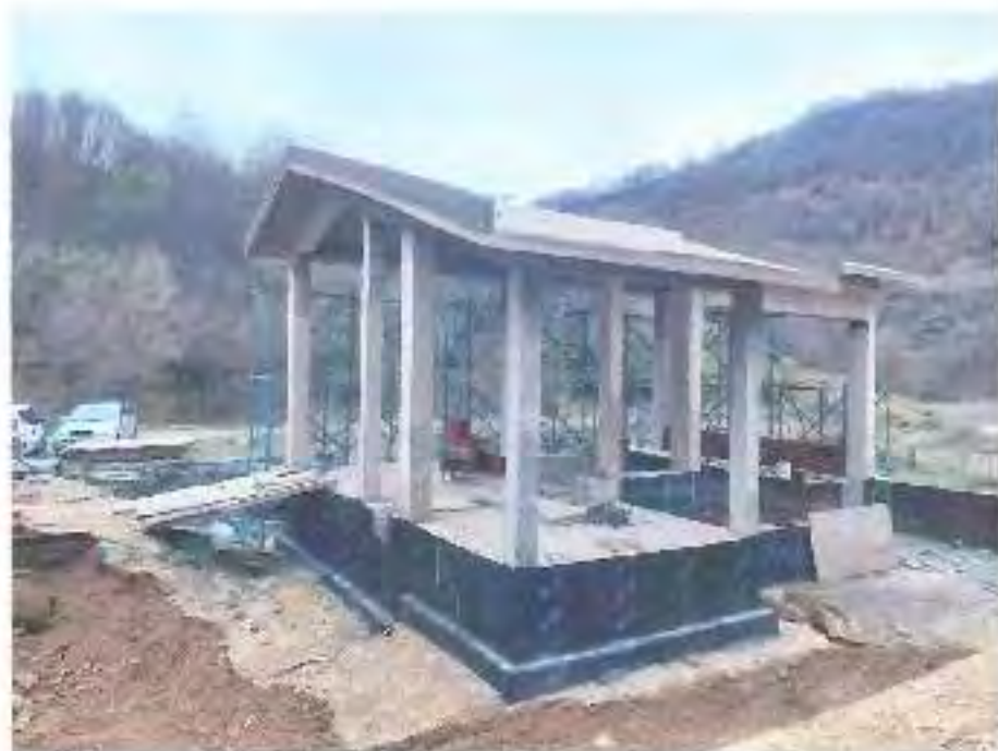
слика 1 - Бетонска конструкција на машинската зграда на ХЕЦ Б
