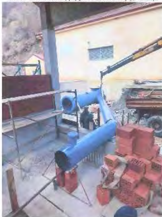
слика 2 - Изградба на црпковод за ХЕЦ Б
